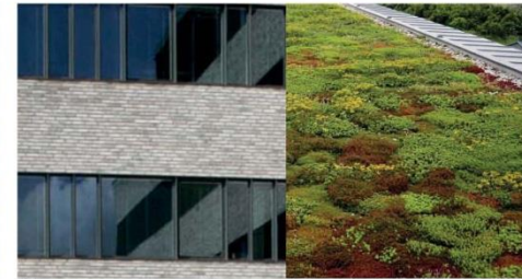
Glas Mörkgrå fönsterprofiler, plåtarbeten och mörkt fasadglas. Sedum på bårhusgaraget och entréers tak.
