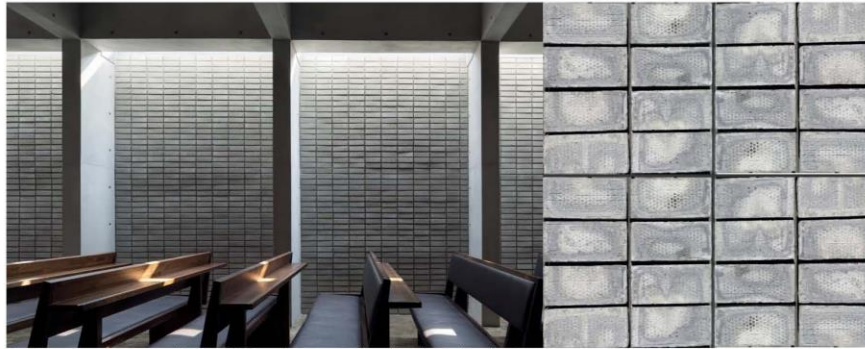
Fondväggar mot öster av tegel Petersen D91 med liggytan vänd som fasad, murad med små imperfektioner som fångar släpljuset och ger en levande väggyta.
