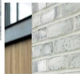
Tegel Fabrikat Petersen D91, grådämpat handslaget, ljus, homogen sortering med slät, ljus fog Dansk normalformat (DNF)
