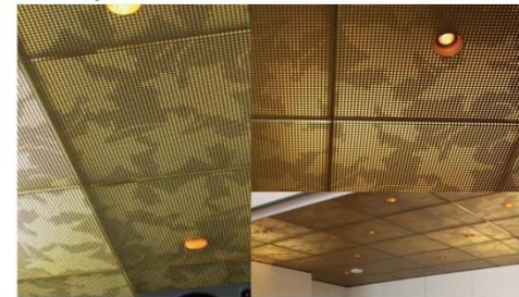
Metall Undertak av metall, champagne/guldfärgat med infälld och bakomliggande belysning, typ Urban forest/itaab.
