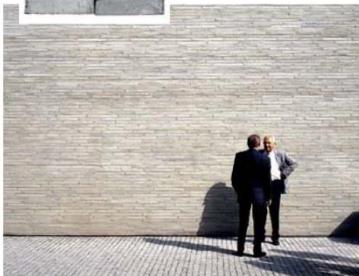
Tegel Fabrikat Petersen D91, grådämpat handslaget, mörk varierad sortering med mörk, tryckt fog 20 mm Flensburgsformat (FF)
